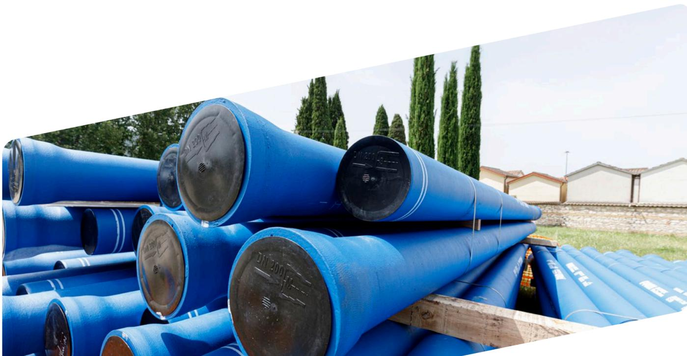
“La scelta del materiale da adottare per la costruzione delle condotte di distribuzione comporta la valutazione di alcuni parametri rivolti sia alla **tutela della qualità dell'acqua da distribuire che alle caratteristiche chimico-fisiche dei terreni**. La scelta è ricaduta su tubazioni in ghisa sferoidale, un materiale di elevata resistenza e durabilità che, a differenza dell'acciaio, non ha bisogno di particolari protezioni dalla corrosione come quelle attive catodiche o a corrente impressa.”
